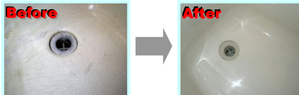
②浴槽の壁に広がったクラック (ひび割れ)
