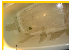
⑤浴槽の底と壁面(部分)のガラスクロスライニング
