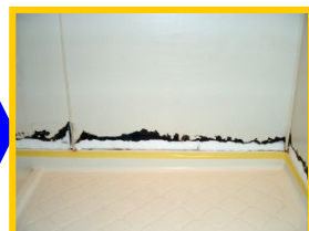
④サビ処理後、バックアップ材で補強
