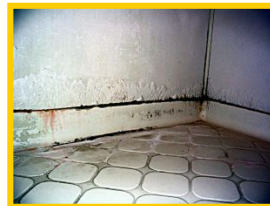
④サビ処理後、バックアップ材で補強
