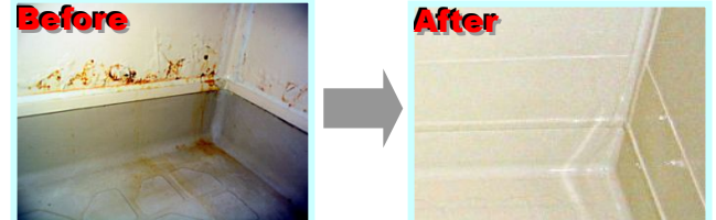
④鋼板のサビで膨らんだ壁（水栓接合部）
